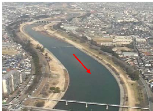
図 2-3 下流部築堤区間
