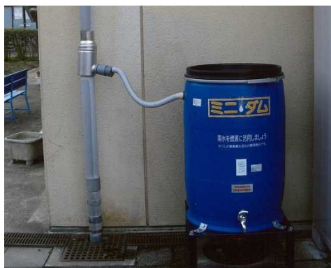
図 6-16 その他の雨水貯留・浸透の取り組み（左：雨水貯留タンク、右：浸透管・浸透樹）
