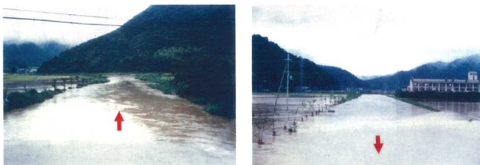
図 1-8 平成 8 年洪水の浸水状況
