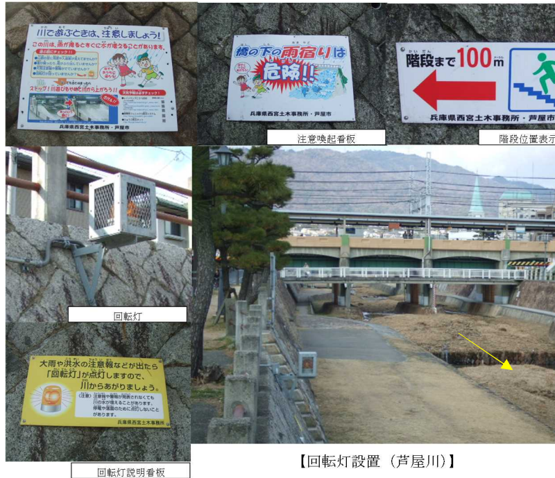
図 7-7 回転灯の設置
