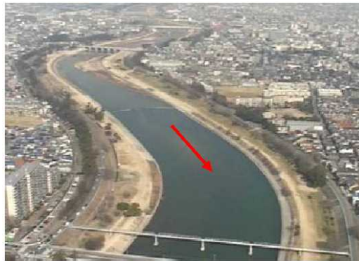
図 2-3 下流部築堤区間
