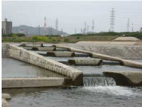
図 2-6 床止めに設置された魚道
