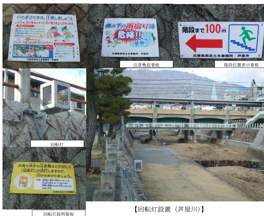
図 7-6 回転灯の設置
