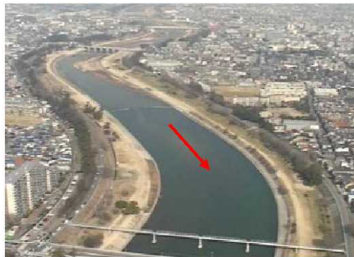
図 2-3 下流部築堤区間
