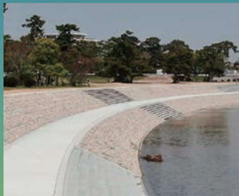
武庫川の護岸整備
