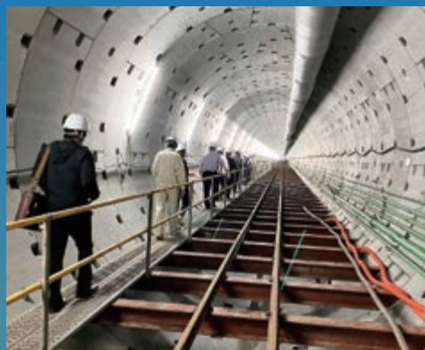
津門川地下貯留管
