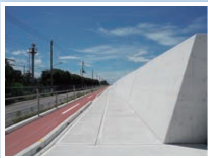
①丸島地区西護岸(尼崎)
