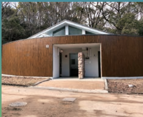
甲山森林公園トイレリニューアル
