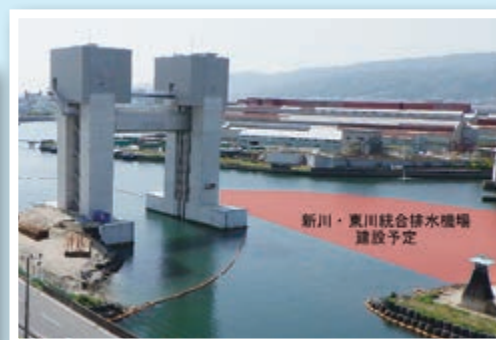
⑨新川・東川統合排水機場(西宮)
