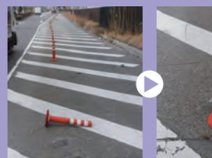
ラバーポール再設置
