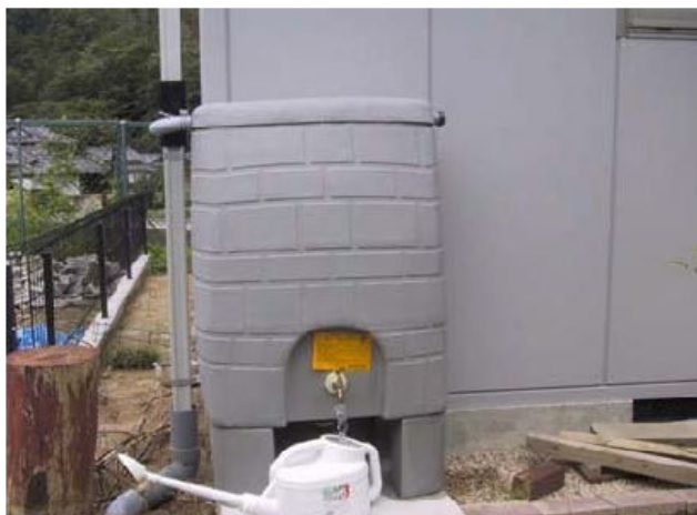
雨水貯留タンク
