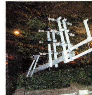
道路陥没で倒れた電柱（午後8時15分ごろ、西宮市生瀬武庫川側で）
