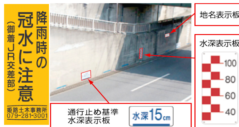
【注意喚起看板等の冠水対策】
