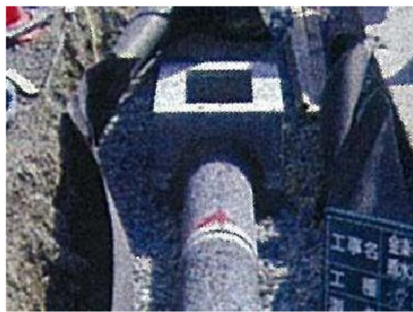
道路側溝の浸透化
