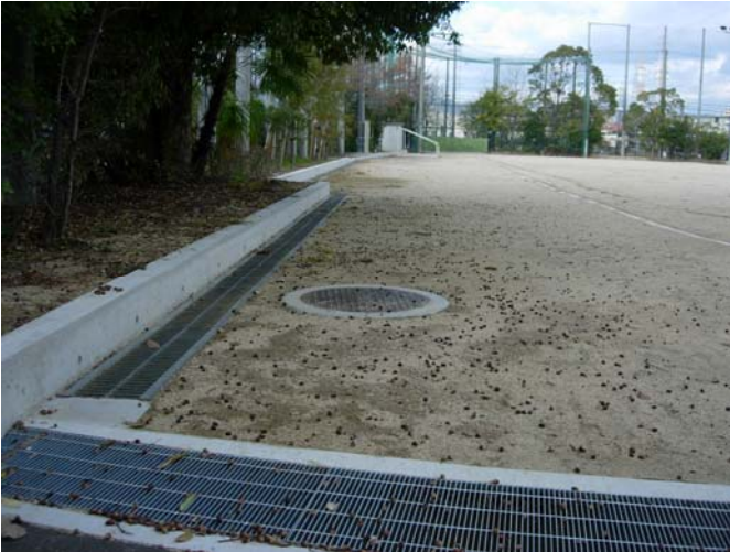
雨水貯留施設 (周囲小堤)
