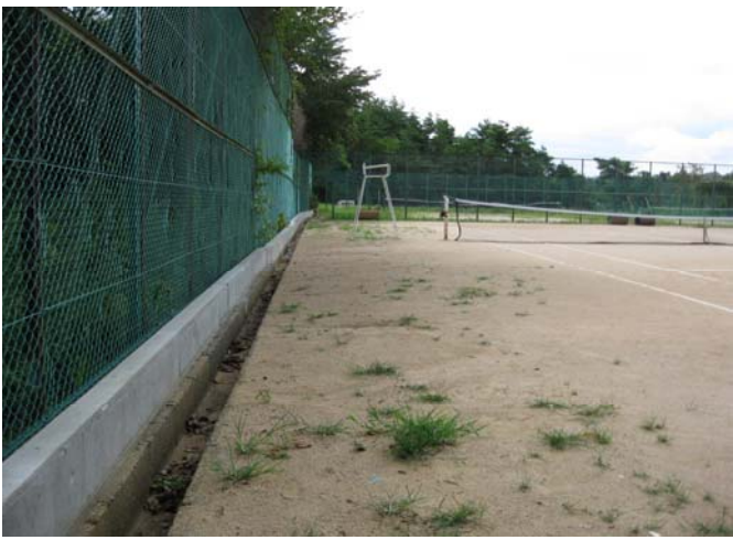
雨水貯留施設 (周囲小堤)
