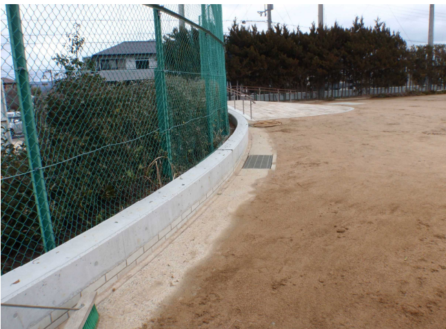
雨水貯留施設（周囲小堤）
