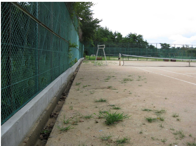
雨水貯留施設(周囲小堤)
