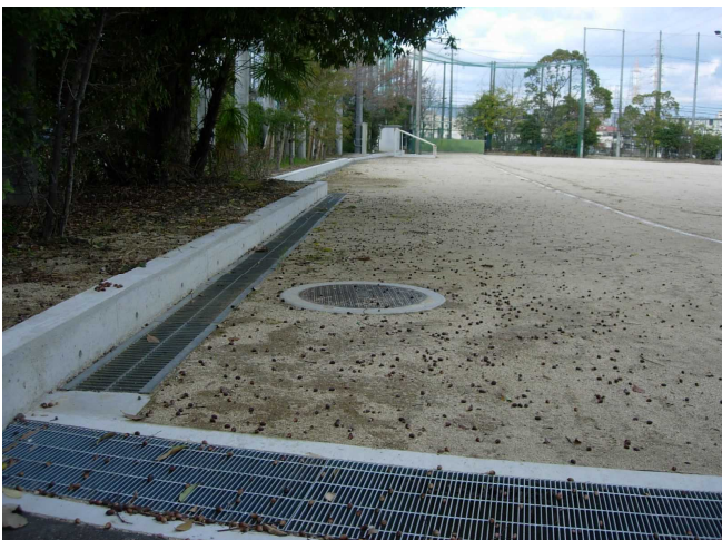
雨水貯留施設（周囲小堤）
