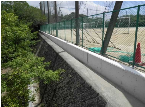
雨水貯留施設 (周囲小堤)
