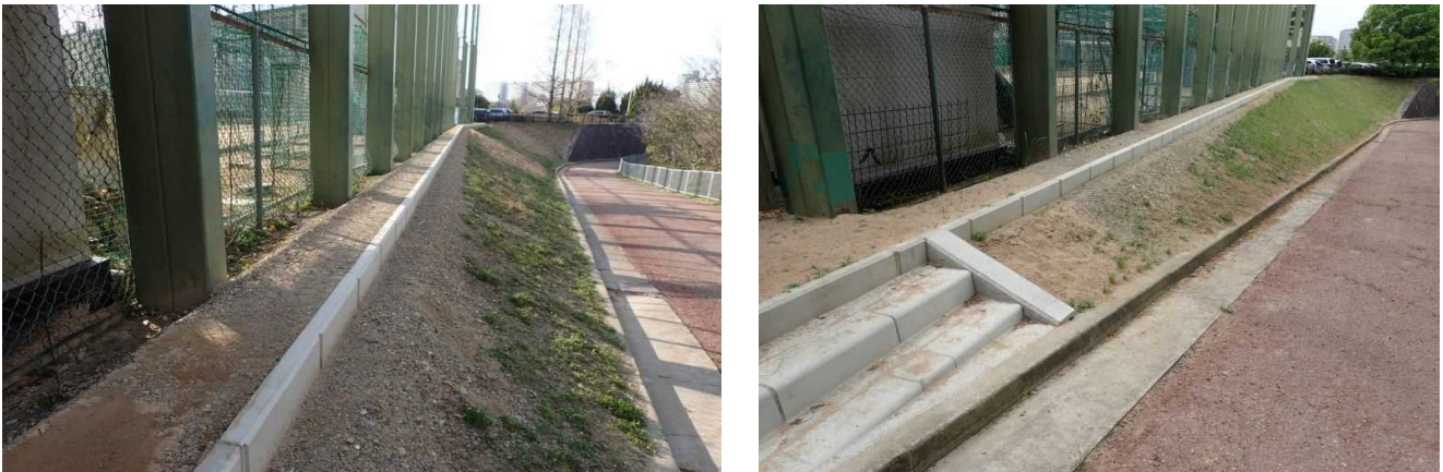
雨水貯留施設 (周囲小堤)
