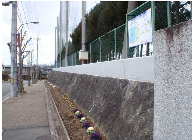
雨水貯留施設（周囲小堤）
