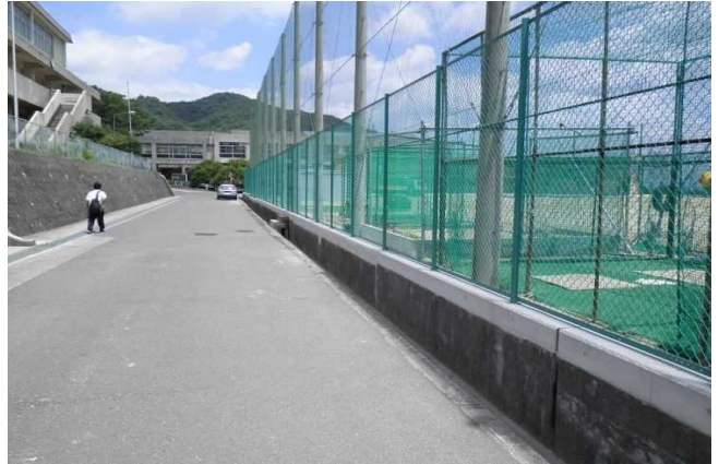
雨水貯留施設 (周囲小堤)
