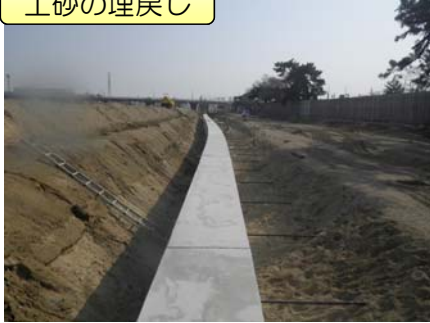
土砂の埋戻し
