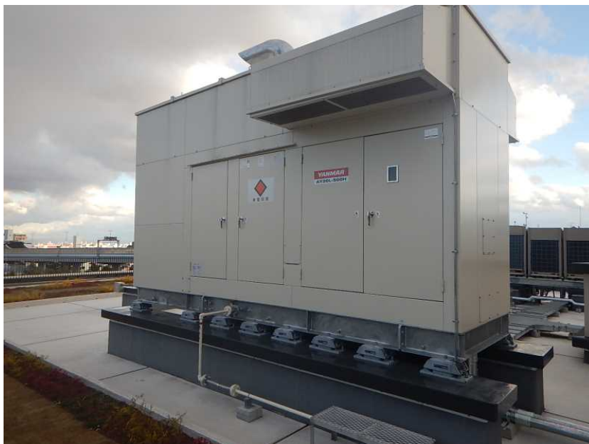
自家発電装置を庁舎屋上に設置
