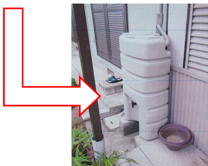
雨水貯留タンク設置例（宝塚市）
