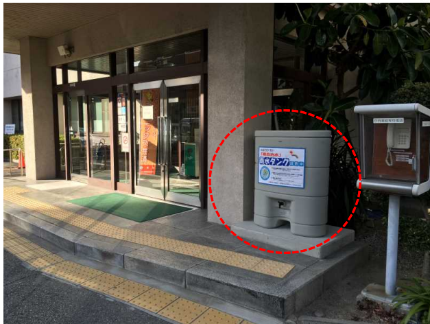
雨水貯留タンク（西宮庁舎）
