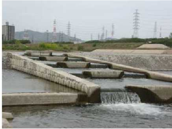
図 2-6 床止めに設置された魚道
