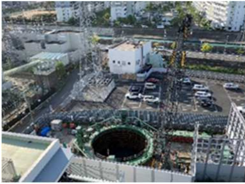
合流貯留管<105路線>立坑(R2)
