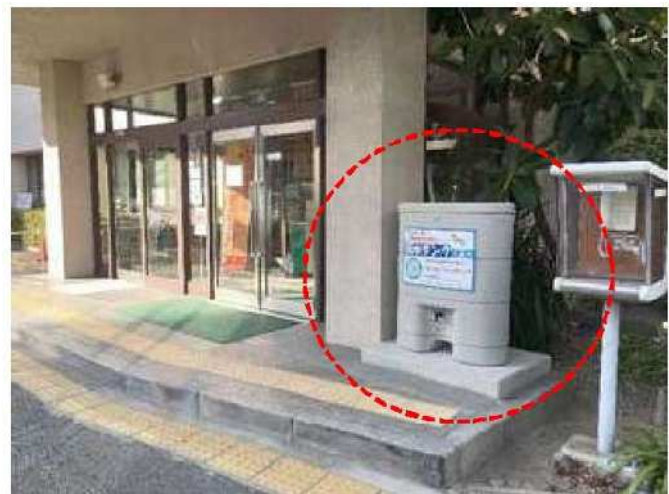
雨水貯留タンク（左：三田庁舎、右：西宮庁舎）
