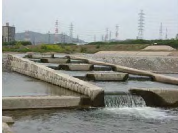
図 2-6 床止めに設置された魚道
