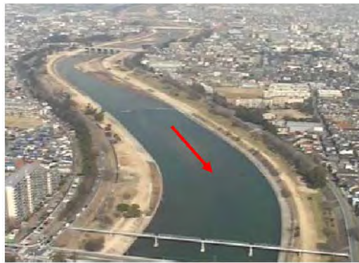
図 2-3 下流部築堤区間
