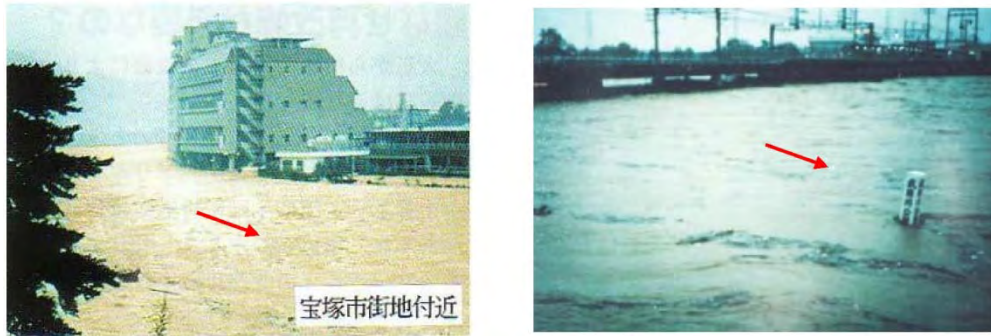
図 1-3 昭和 58 年洪水の状況
