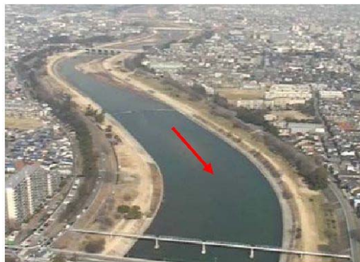
図 2-3 下流部築堤区間
