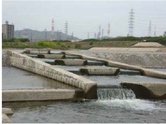
図 2-6 床止めに設置された魚道
