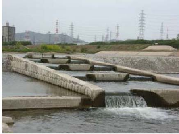
図 2-6 床止めに設置された魚道
