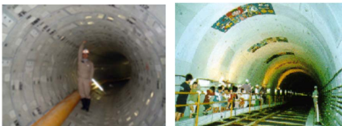
図 5-12 雨水貯留管（左：西宮市、右：伊丹市） （出典：西宮市下水道ビジョン、伊丹市ホームページ）
