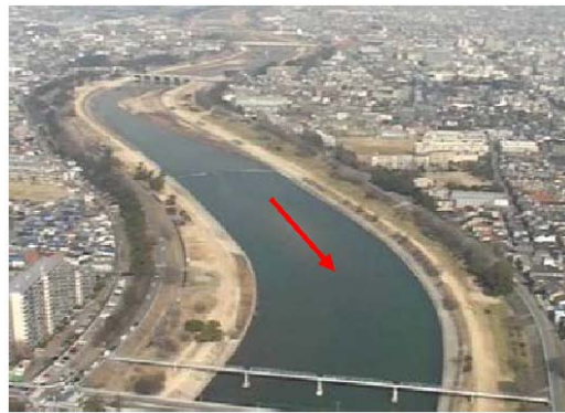
図 2-3 下流部築堤区間
