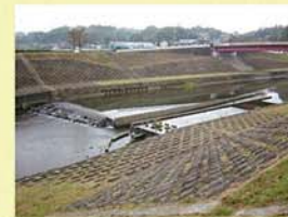
既設床止工に魚道等を設置し魚類等の移動阻害を改善した事例(三田市)
