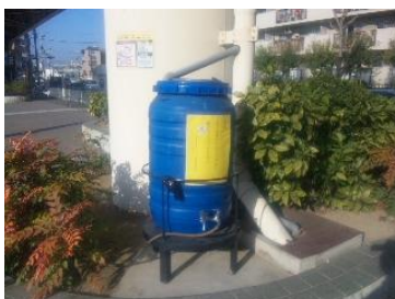
鉄道駅前の連絡通路下(川西市)
