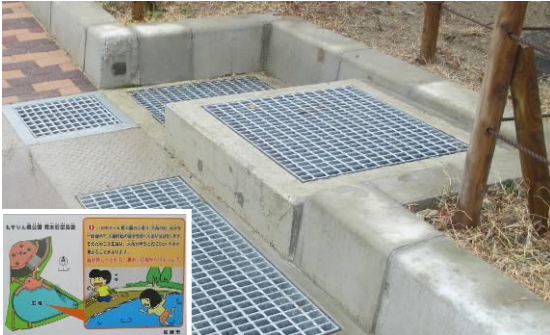
【公園貯留】 もすりん橋公園(尼崎市)
