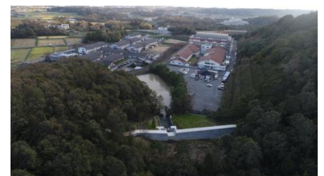
下流の保全対象と完成した 西安谷川砂防堰堤（三田市）
