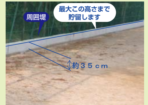
校庭を「周囲堤」で囲み、雨水を貯留します
