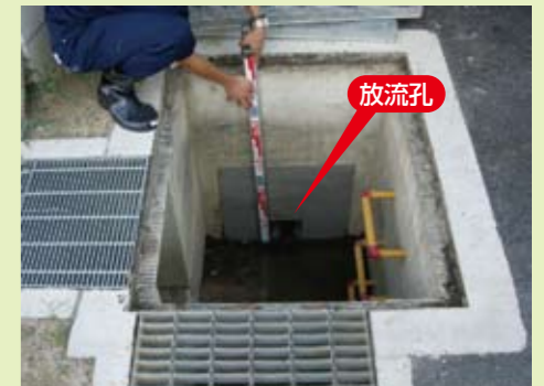
貯留した雨水は、放流孔(約10~20cmの小さな穴)から少しずつ校外へ流します
