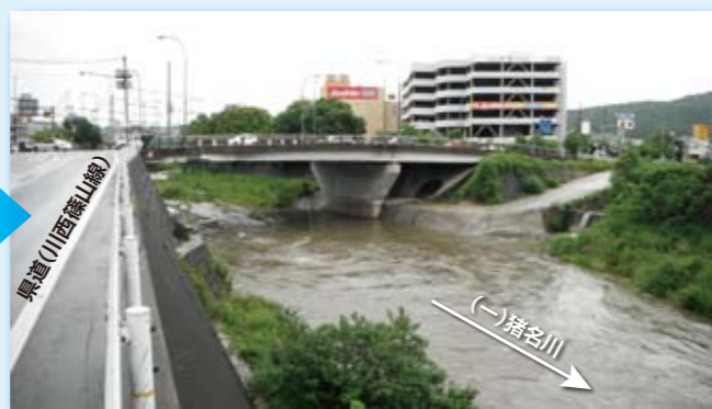
掘削後の状況(H24年6月)
