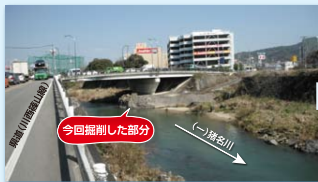
掘削前の状況(H24年3月)
