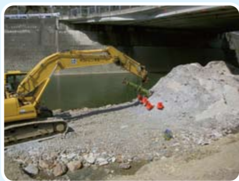
掘削工事の状況(H24年4月)
