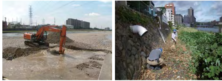
堆積土砂撤去
