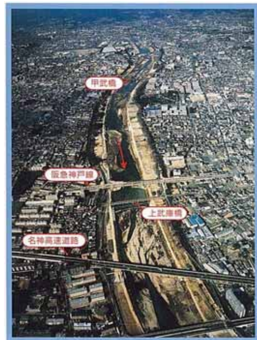
図 2.2.4 武庫川下流上空より
