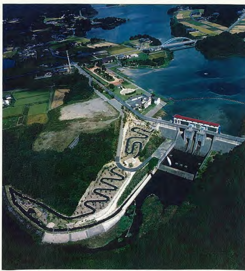
図 2.2.12 青野ダム多自然型魚道
