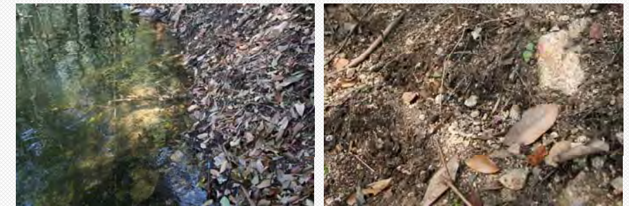
写真、汀線付近の侵食状況
