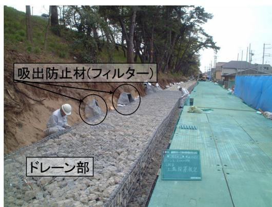
写真 2.2.4 堤防強化工事の例（ドレーン工）
