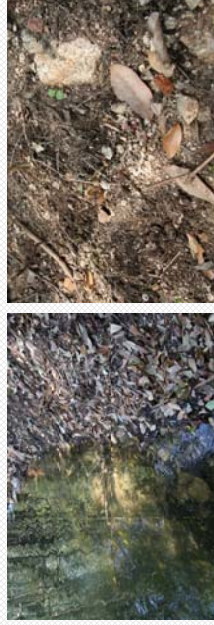
写真、汀線付近の侵食状況
