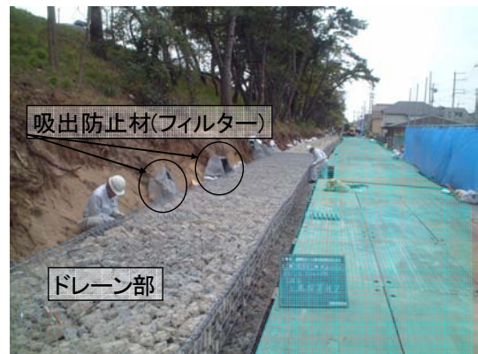
写真 2.2.4 堤防強化工事の例（ドレーン工）
