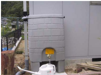
写真 2. 2. 10 雨水貯留タンク
