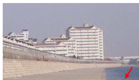
写真 2.2.5 高潮対策事業で整備した防潮堤
