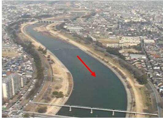
写真 2.2.1 下流部築堤区間
