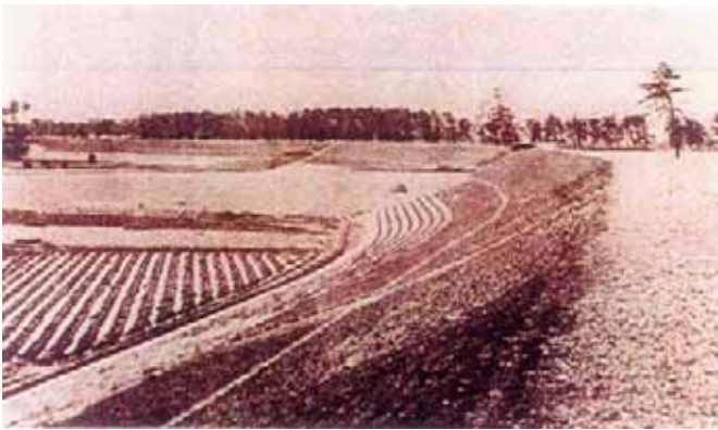
西大島堤防 (武庫川改修第一期工事竣工) 大正時代
