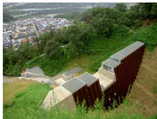
図 4.3.6 人家を守る土石流対策えん堤 高雄谷川（西宮市塩瀬町生瀬）
