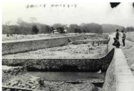
図 4.3.5 流路工施工後の昭和初期の逆瀬川
