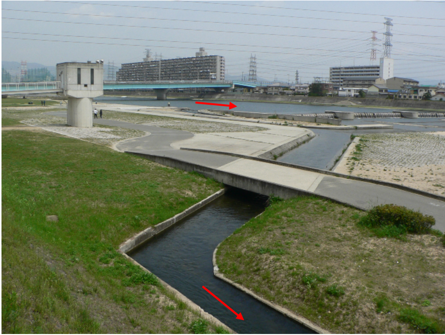
百間樋井堰と導水路（西宮市）
