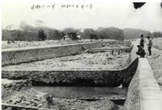
図 4.3.5 流路工施工後の昭和初期の逆瀬川
