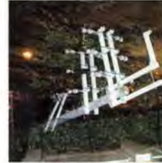
道路崩壊で倒れた橋柱（19日午後5時ごろ、神戸市消防局撮影）
