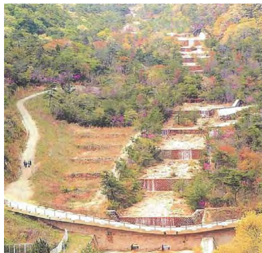
写真 2.1.10 太多田川砂防えん堤群
