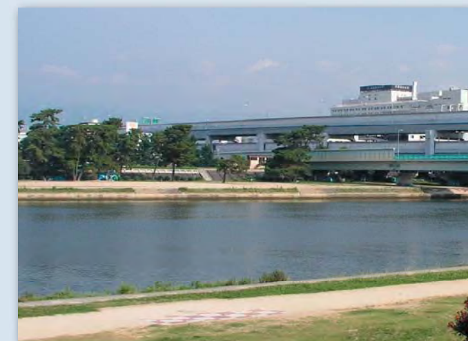
河口部に見られるコンクリート護岸化が進行した場所
