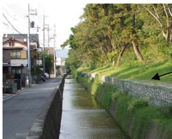
写真 4.1.1 ドレーン工法※の施工例
