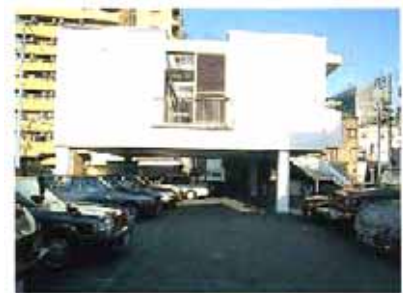
ピロティー式建築(鶴見川での事例)
