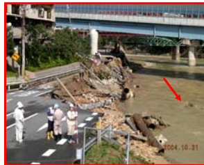
生瀬橋上流右岸側
