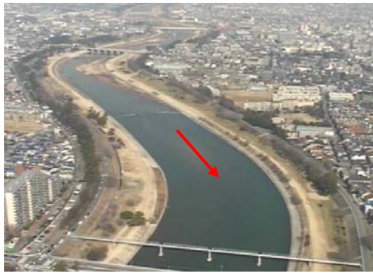
写真 2.2.1 下流部築堤区間
