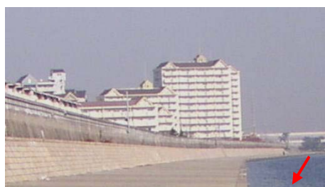
写真 2.2.5 高潮対策事業で整備した防潮堤
