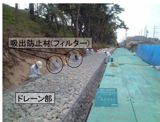
写真 2.2.4 堤防強化工事の例（ドレーン工）
