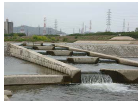
写真 2. 2. 20 床止めに設置された魚道
