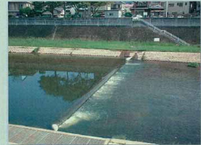
上流部に見られるコンクリート護岸化が進行した場所
