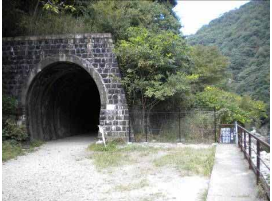
いつでも閉鎖が可能な 状態 090925 (北山第1トンネル 入口)
