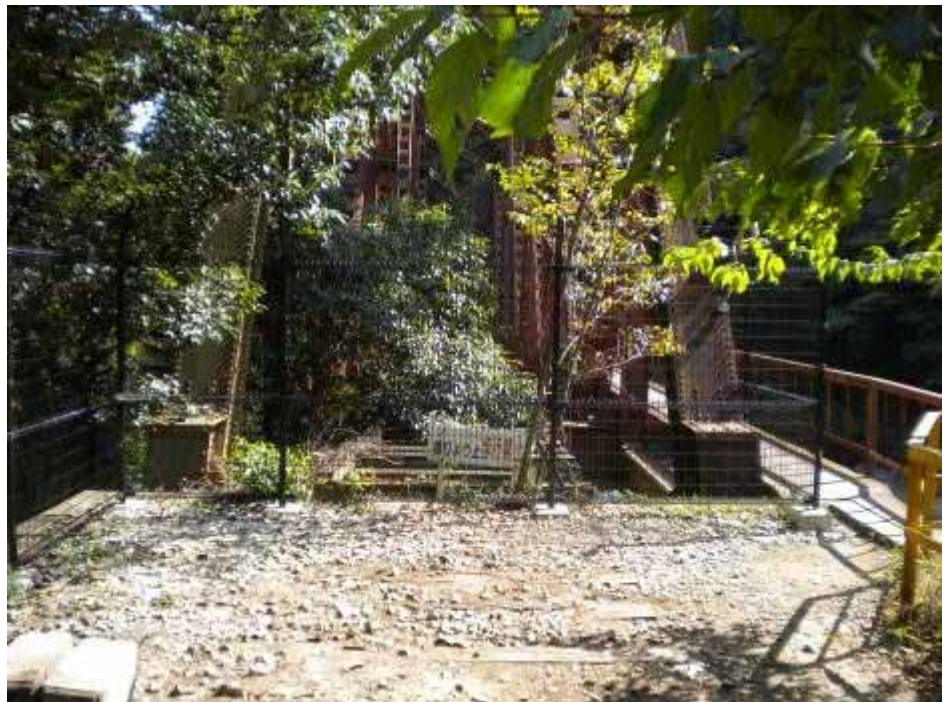
同 090925 (第2 武庫川橋梁北詰)
