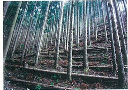
災害に強い森づくり(間伐木を利用した土留工)
