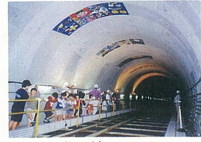
雨水貯留管(伊丹市)
