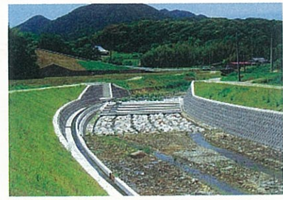
河川改修 鮎屋川(洲本市)
