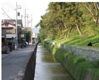
写真 4.1.1 ドレーン工法※の施工例
