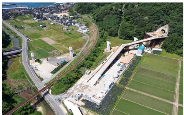
浜坂道路Ⅱ期 浜坂第2トンネル～ 諸寄高架橋（新温泉町）
