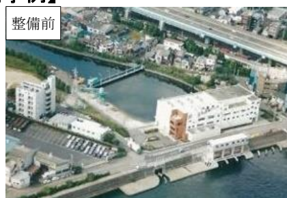
排水機場(更新)
