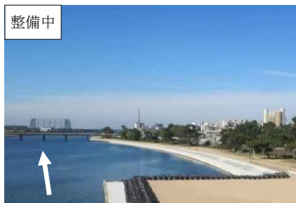
河川改修(護岸、河床掘削等)
