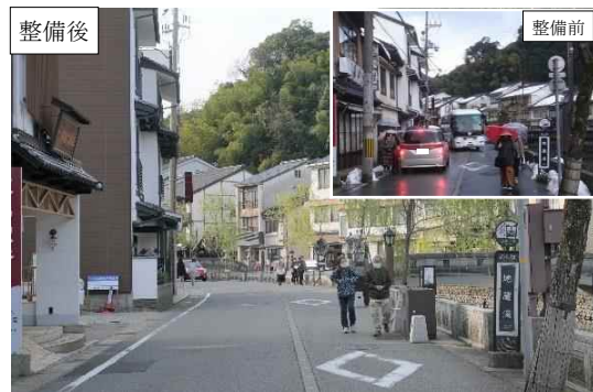
無電柱化対策
