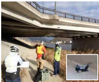
橋梁点検(ドローン撮影)
