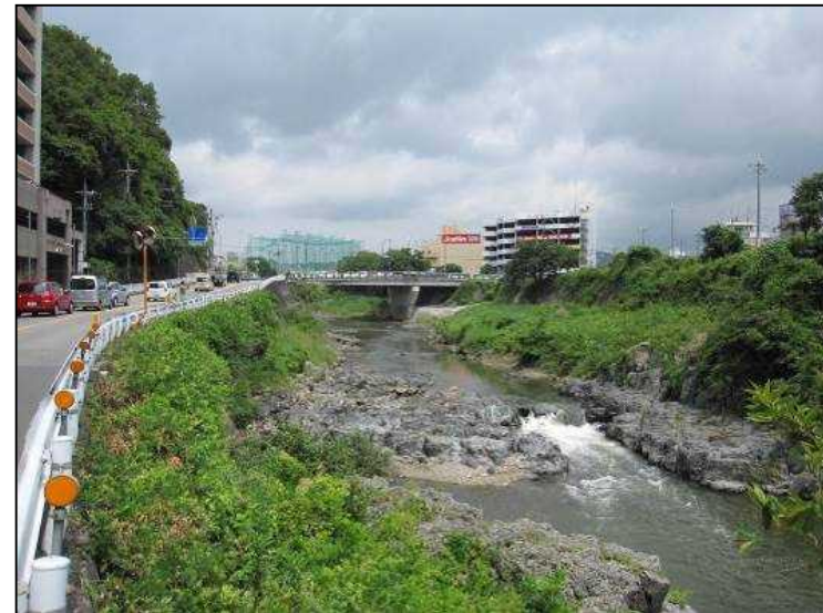
銀橋下流(中流部)
