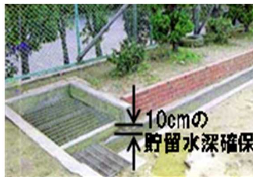
学校(校庭)における雨水貯留 (川西南中学校)
