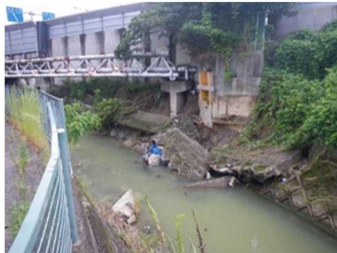
駄六川 国道171号上流部
