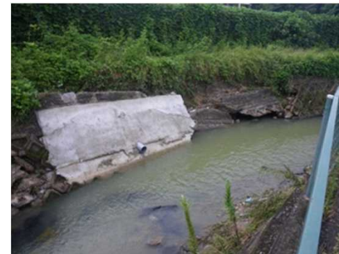
駄六川 国道171号上流部
