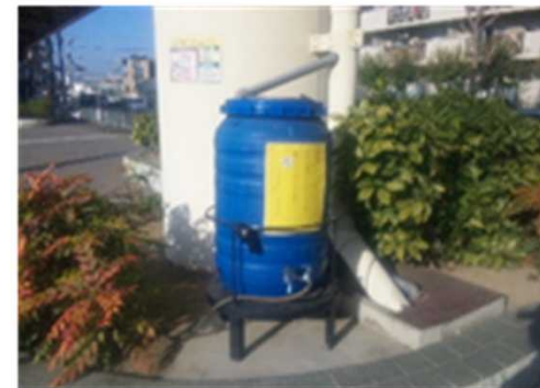
雨水貯留タンク (川西市)
