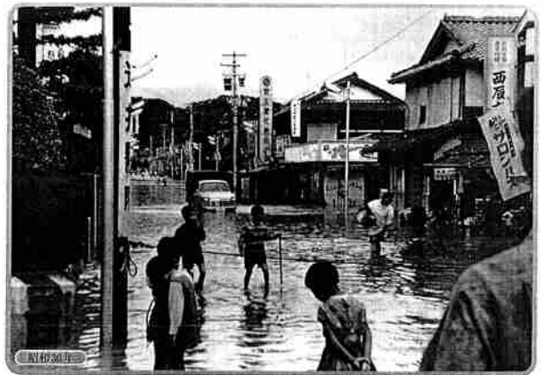
昭和36年6月24日から降り出した雨は、26日の午後3時までに255ミリに達した。武庫川は氾濫水位27メートルを大きく上回り、4.5メートルに達した。市では各町会本部を設け、水回社員1000人を動員して警戒にあたる一方、住民3000人に避難命令を出し、三輪小学校などに避難所を設けた。市内で床上浸水300戸、床下浸水430戸のほか、橋の流失2か所、がけくずれ4か所、道路の冠水などの被害は約1箇所にも達した。
