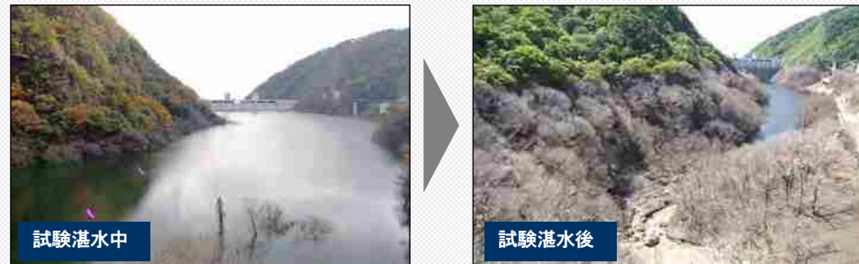
図. 石井ダムにおける試験湛水の実施状況
