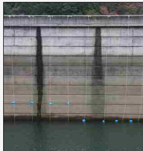
図. 耐水圧試験の実施状況
