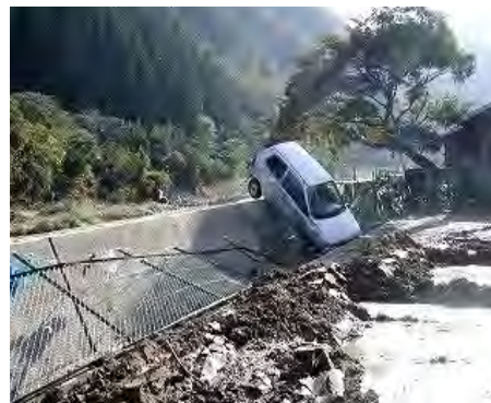
写真 2.2.3 平成 16 年台風 23 号の被災写真（武田尾地区）
