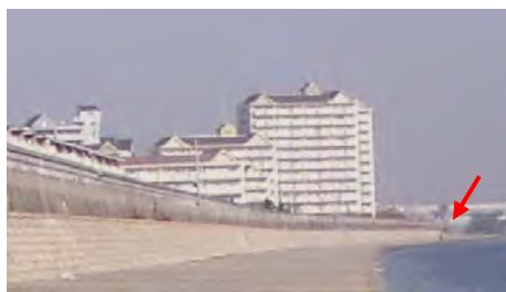
写真 2.2.5 高潮対策事業で整備した防潮堤
