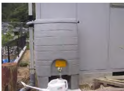
写真 2. 2. 10 雨水貯留タンク
