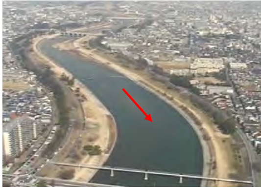
写真 2.2.1 下流部築堤区間
