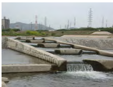
写真 2. 2. 24 床止めに設置された魚道
