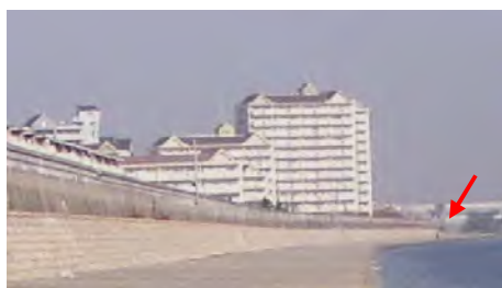
写真 2.2.5 高潮対策事業で整備した防潮堤
