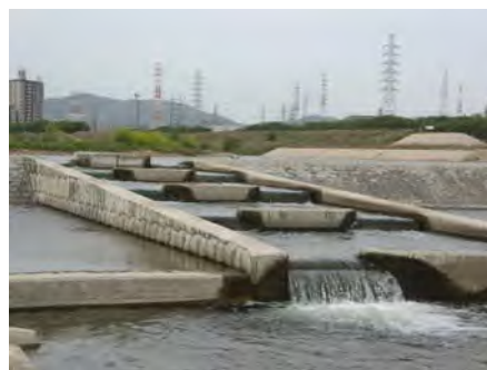
写真 2.2.24 床止めに設置された魚道
