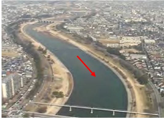
写真 2.2.1 下流部築堤区間
