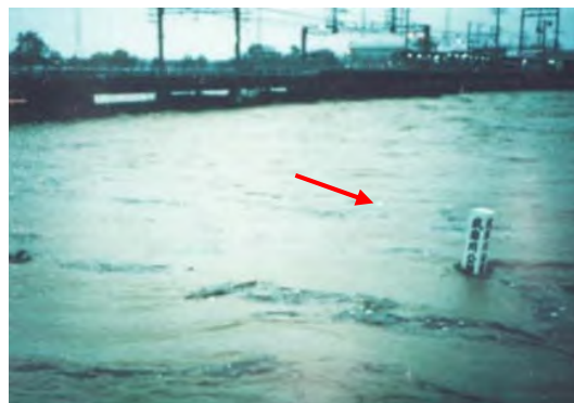
写真 2.1.7 昭和58年 災害台風10号 による 洪水 の状況（阪神電鉄橋梁付近）
