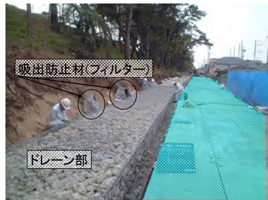
写真 2. 2. 4 堤防強化工事の例(ドレーン工)
