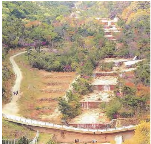
写真 2.1.10 太多田川砂防えん堤群
