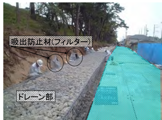
写真 2. 2. 4 堤防強化工事の例(ドレーン工)
