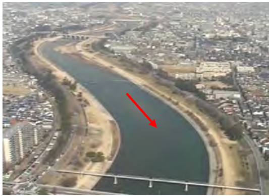
写真 2.2.1 下流部築堤区間
