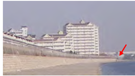
写真 2.2.5 高潮対策事業で整備した防潮堤
