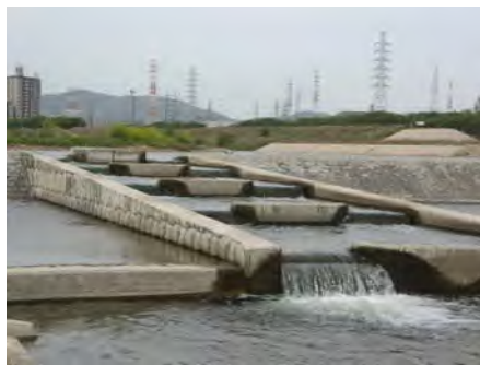
写真 2.2.24 床止めに設置された魚道
