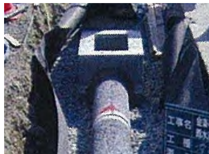
写真 2.2.11 浸透側溝
